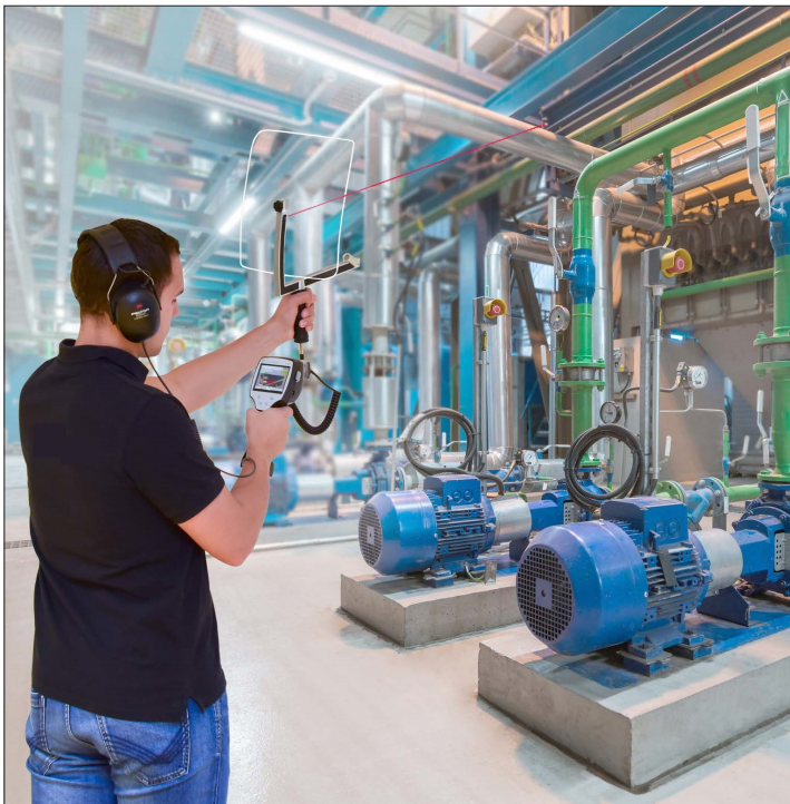
Punktgenaue Leckageortung im laufenden Betrieb mit Laserpointer und integrierter Kamera
